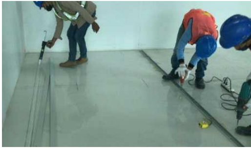
(b) Pemasangan Kanal C
