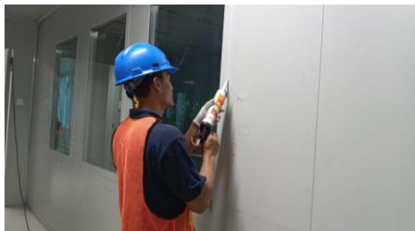
Gambar 17. Pemasangan Sealant (Sumber : Dokumen 2022, diolah)
