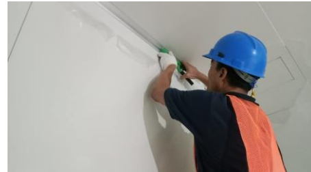
(b) Proses Pemasangan Extrusion
