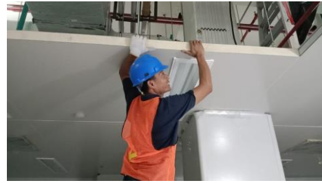
(a) Proses Pemasangan Plafond
