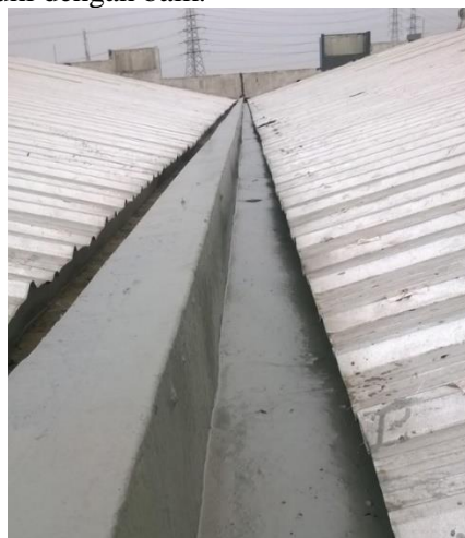
Gambar 6. Talang air Beton (Sumber : google.com)
