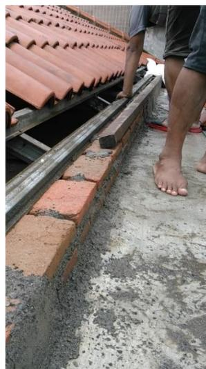
Gambar 1. Pengecekan dan penyetulan sudut genteng di atas talang beton
