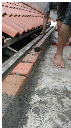
Gambar 1. Pengecekan dan penyetelan sudut genteng di atas talang beton
