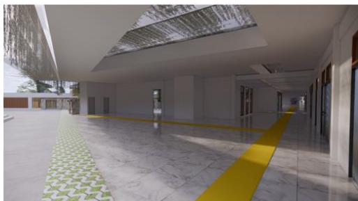
Gambar 14. Platform Kedatangan Penumpang (Sumber: Penulis, 2024)
