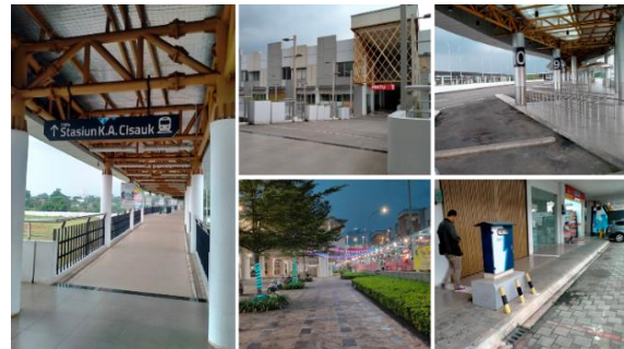
Gambar 5. Kondisi sirkulasi horizontal dan akses masuk ke tapak dan bangunan (sumber: dokumentasi pribadi, 2022)
